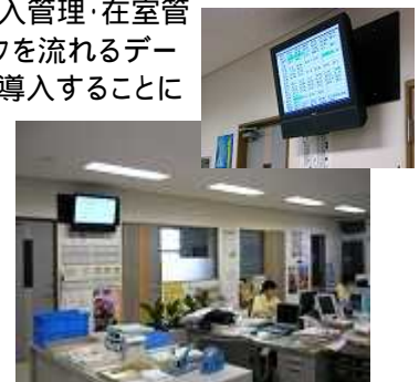
上: 事務所内の壁に設置された在室表示モニター
